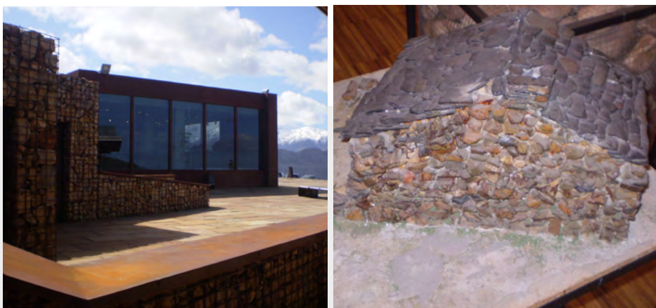
Empleo de materiales pétreos en gaviones. El Soplaio Maqueta construcción tradicional en el Centro de Investigación de Arquitectura Tradicional (CIAT)
