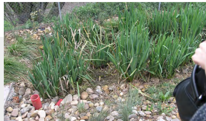
Sistema de depuración biológica de aguas residuales
