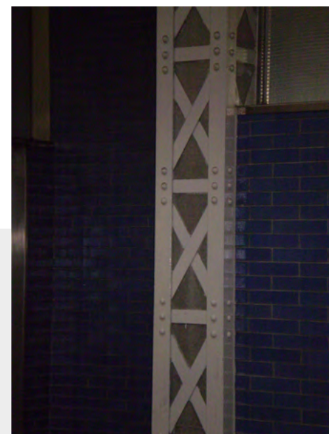
Pilar metálico roblonado en rehabilitación
