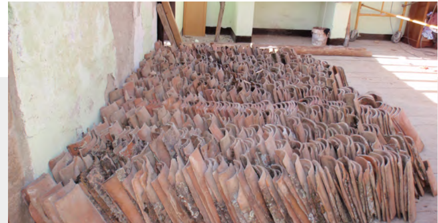
Acopio de teja cerámica de recuperación
