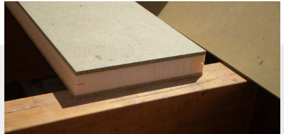
Aislamiento térmico en cubierta con panel sándwich
