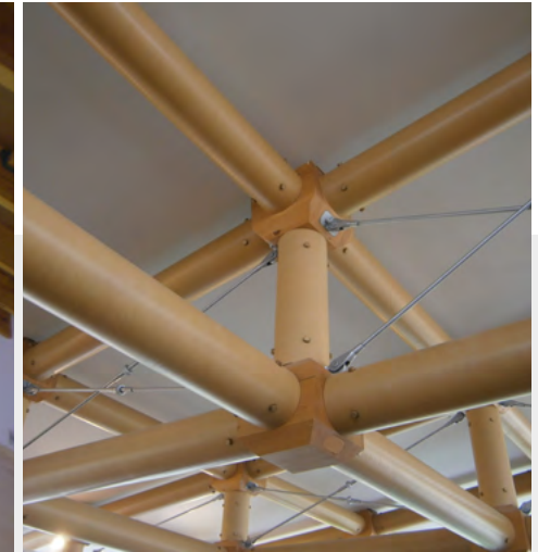
Paper Pavilion. Ejemplo de construcción con cartón
