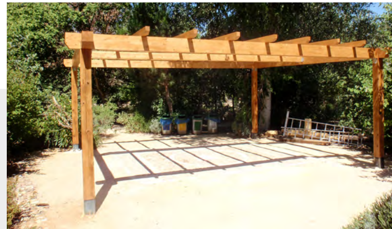
Estructura de madera
