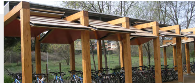
Aparcamiento para bicicletas con módulos fotovoltaicos
