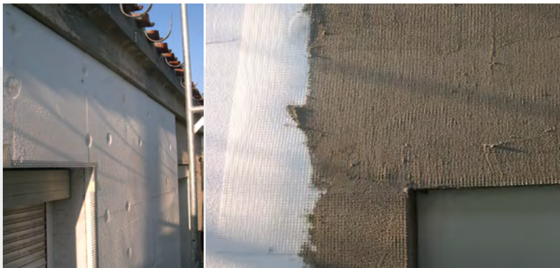
Montando SATE en rehabilitación de fachada
