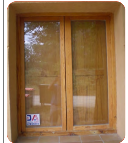
Carpintería exterior de madera local
