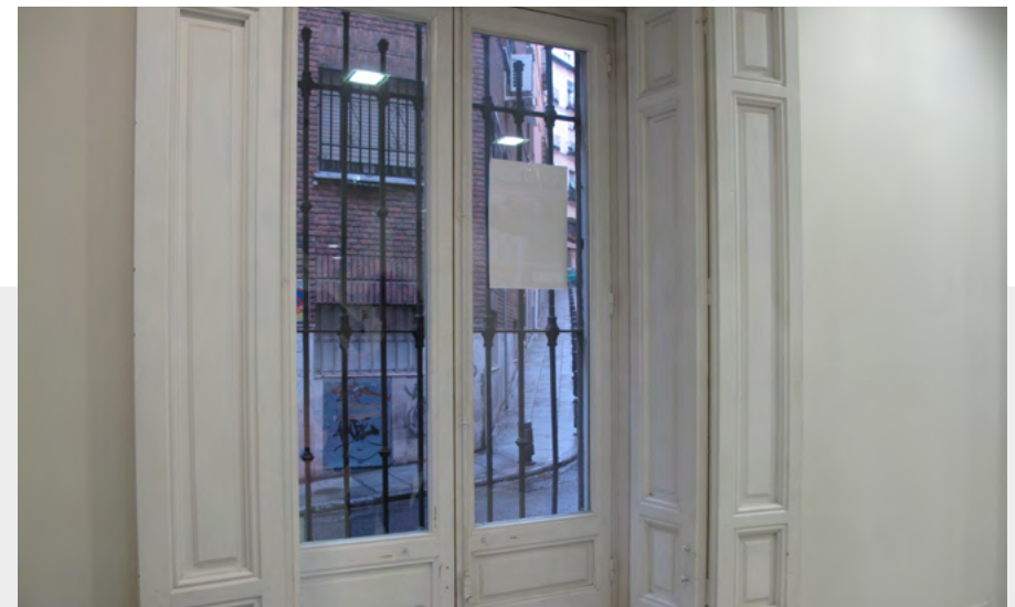
Carpintería exterior de madera con contraventanas interiores
