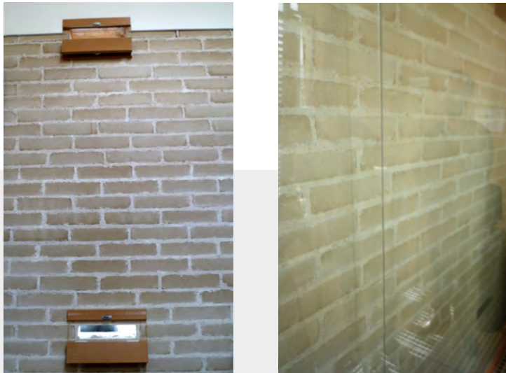
Muro Trombe con Bloque de Tierra Comprimido (BTC)
